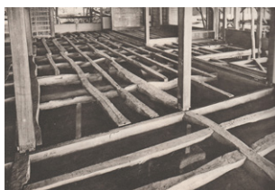
解体中床組状態（手前菖蒲の間） 【奥書院修理工事報告書】
