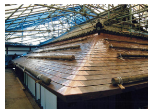
銅板屋根施工完了
