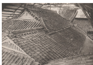
修理前西側屋根
