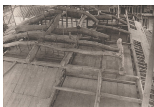
解体中小屋組状態（右下上段の間）
