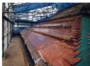
銅板屋根施工中
